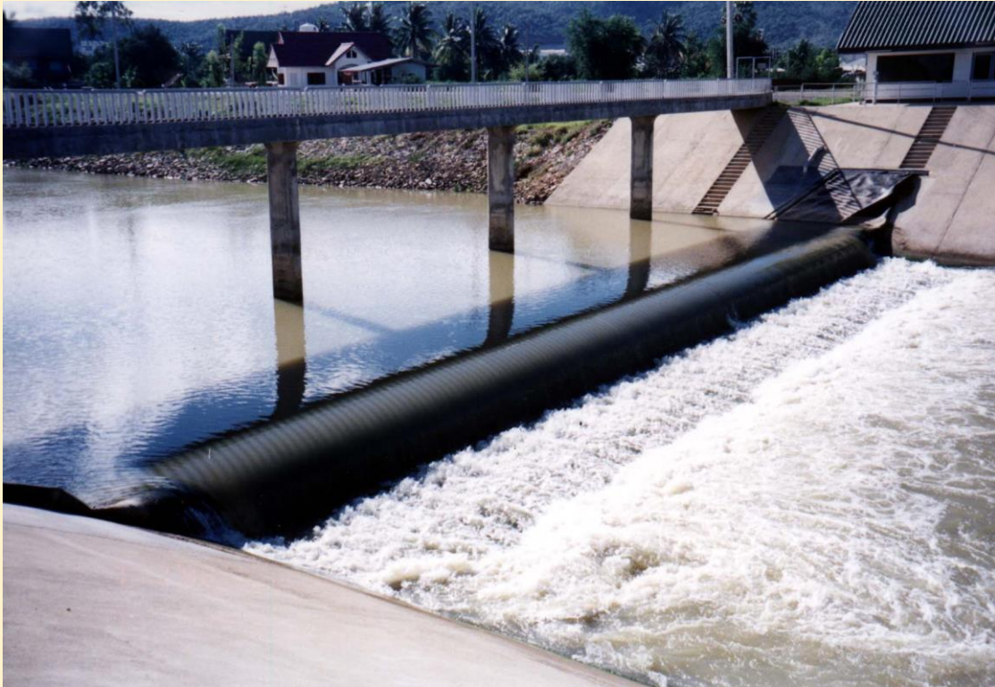
รูปที่ 6 ฝายยางคลองจรเข้สามพัน อำเภออุทุมพร จังหวัดสุพรรณบุรี ความสูง 2.40 เมตร ยาว 30.00 เมตร
