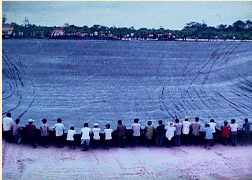
รูปที่ 4 ชาวบ้านกำลังช่วยกันปูแผ่นยางปูอ่างเก็บน้ำ
