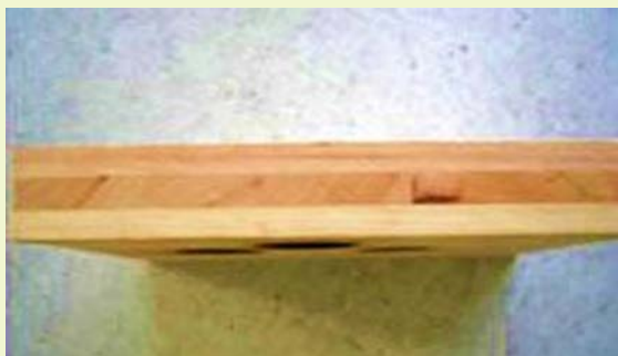
รูปที่ 1 การวางไม้แบบคลอสลามิเนต (cross laminate)
